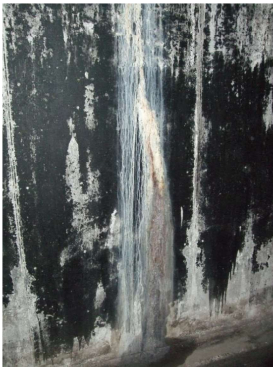
Fot. 10. Białe i rdzawe wykwity na ścianach otaczające rysy
