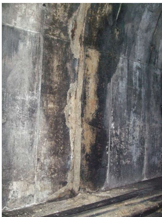
Fot. 6. Zniszczone dylatacje
