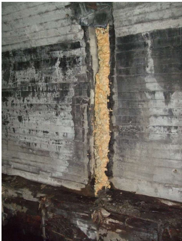
Fot. 4. Nieszczelne zabezpieczenie dylatacji
