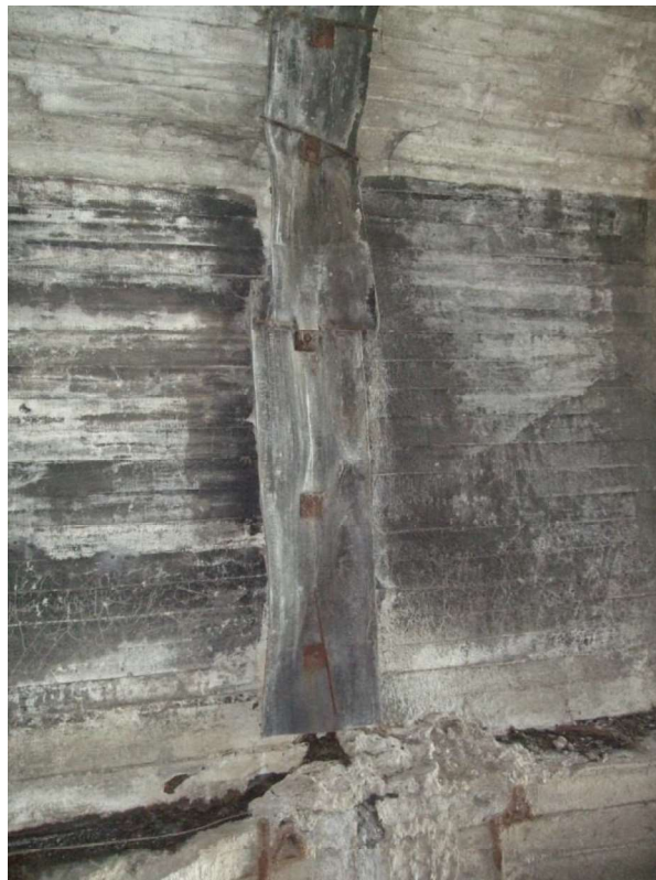
Fot. 4. Nieszczelne zabezpieczenie dylatacji
