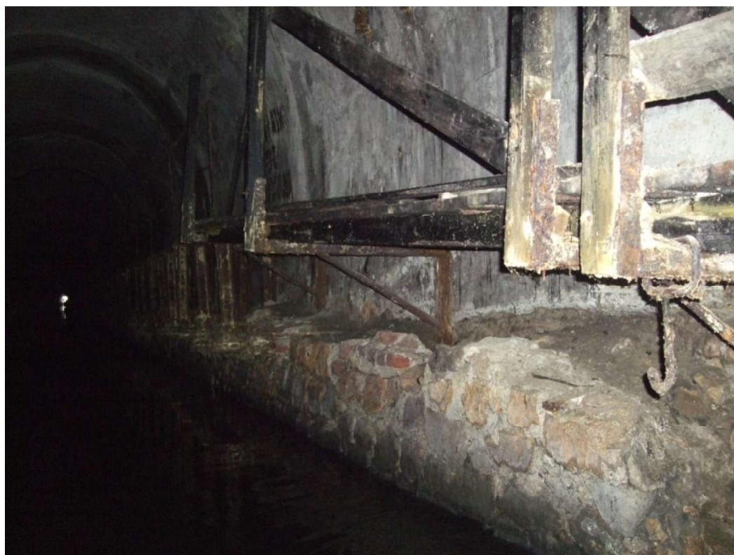
Fot. 3. Oparcie sklepienia na murze, widok pomostu roboczego
