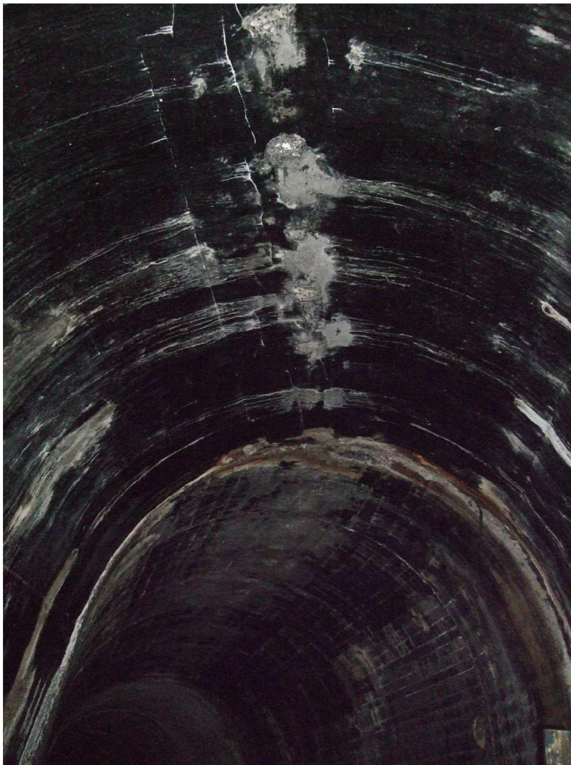
Fot. 9. Rysa pozioma w sklepieniu
